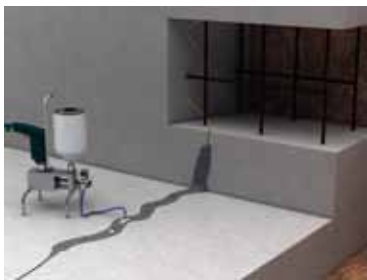
Инъектирование сухих трещин
