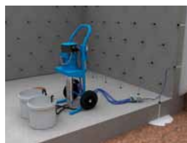
Создание противофильтрационной завесы
