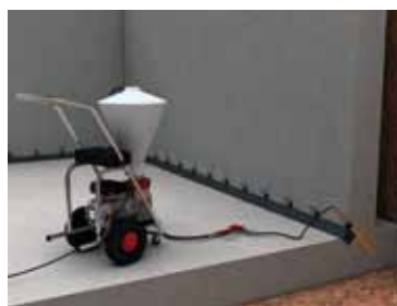
Герметизация рабочих швов
